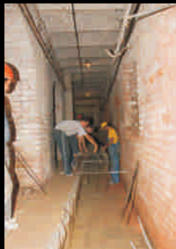
Lucrări de consolidare la Muzeul Colecțiilor de Artă
