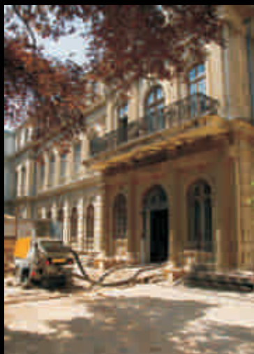
Lucrări de consolidare la Muzeul Colectiilor de Artă
