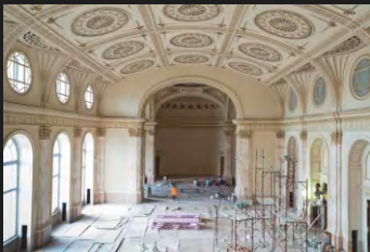
Lucrări de renovare în Sala tronului
